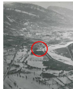
Illustration d'une rupture de digue de l'Isère au Bec de l'Echailon en 1948
