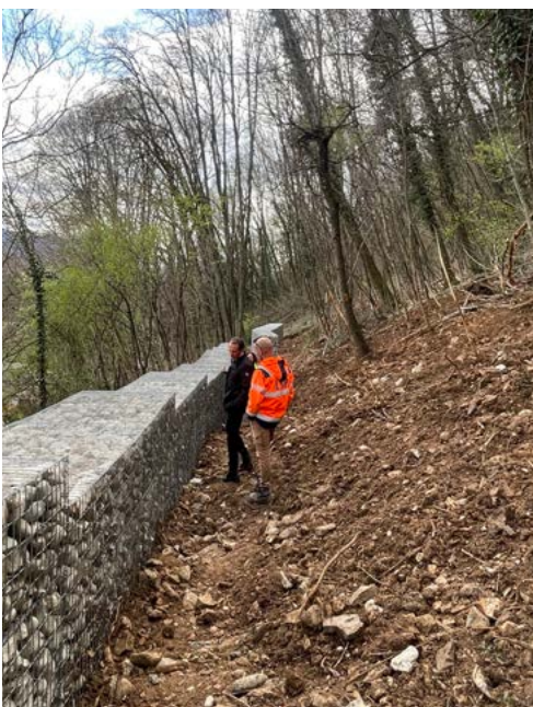
Mars 2025 : Installation de murs gabions en terrain privé, revégétalisés.
